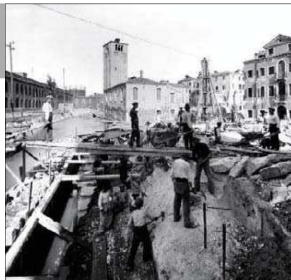
SANTA MARTA In costruzione l'ala del Cottonificio, 1925
